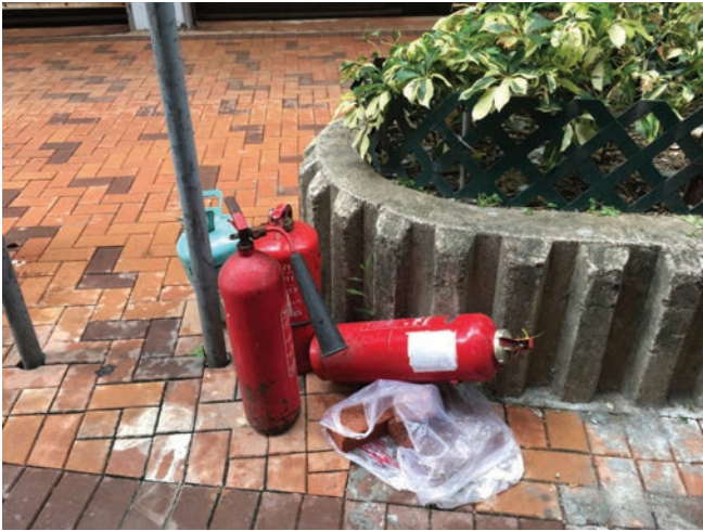
9. 德輔道西343號均益大廈第二期對出花槽旁地
