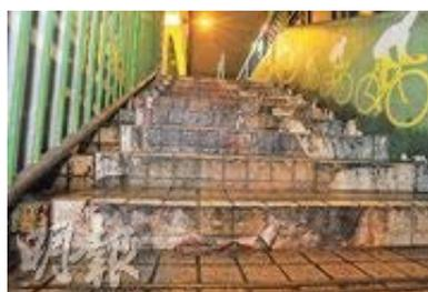
軒尼詩道310號的水墨階梯剝落嚴重，水墨畫主體多處破爛脫色，反之梯旁的油漆圖案未見脫落。（樊銳昌攝）
