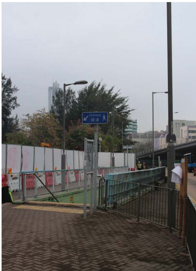
現有行人隧道編號KS32 D出口
