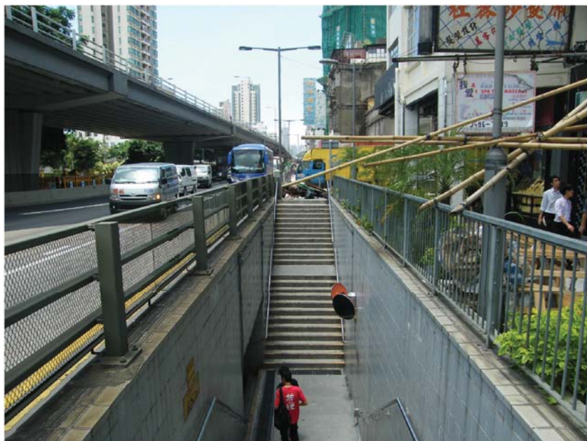
現有行人隧道編號KS9 'A'出口
