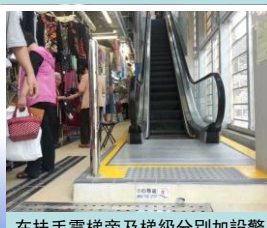
在扶手電梯旁及梯級分別加設警告標示、顏色標貼及鐵柱。
