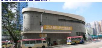
外牆(協和街方向)加裝了出入口指示橫額
