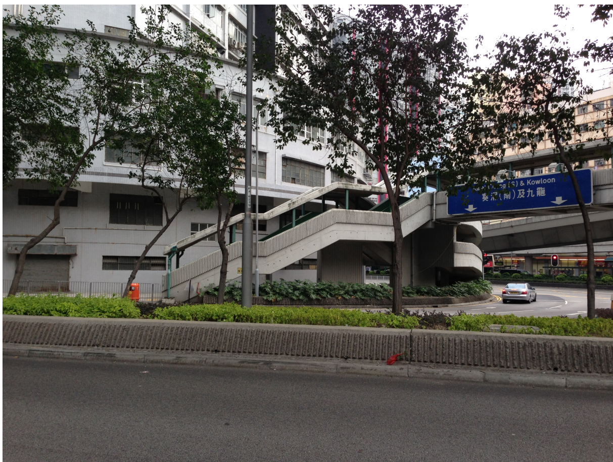
行人天橋 - 施工前 ( 結構編號: NF229 ) B 出口
