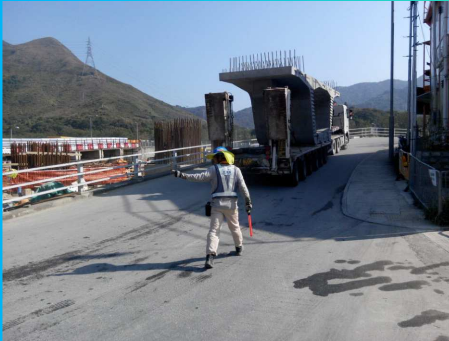
運送行車天橋預製組件的情況
