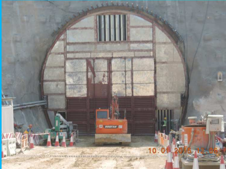
於爆破現場裝上爆破門
