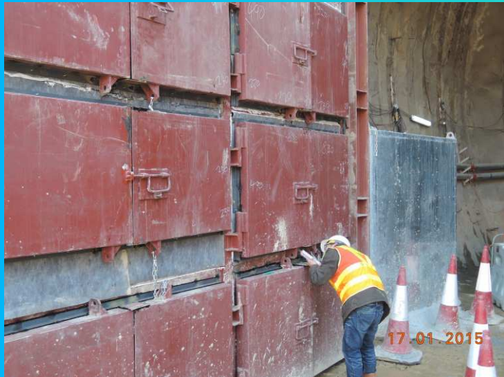
填充爆破門的空隙以減低爆破時的聲音
