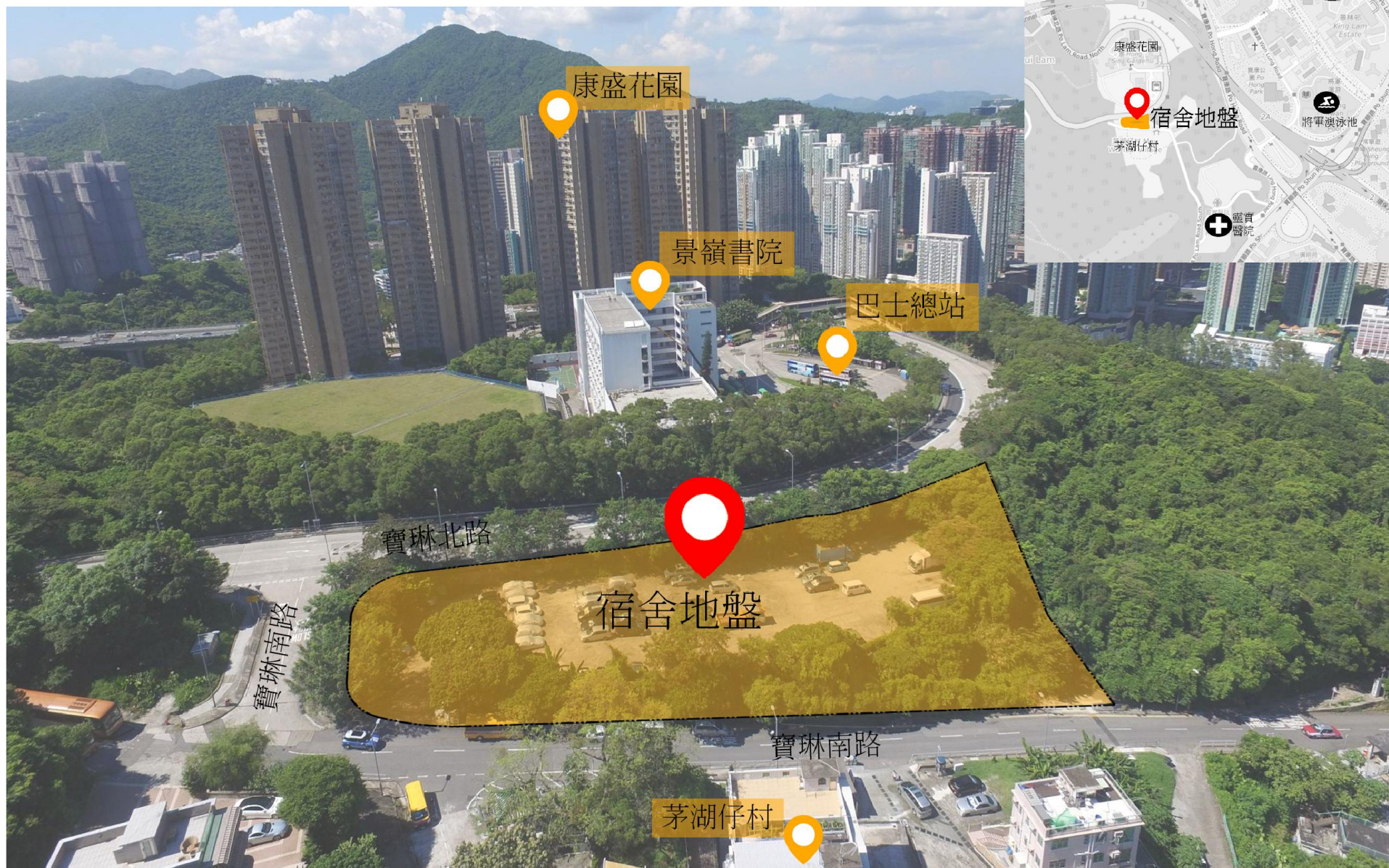
將軍澳第123區寶琳路香港海關職員宿舍建造工程
