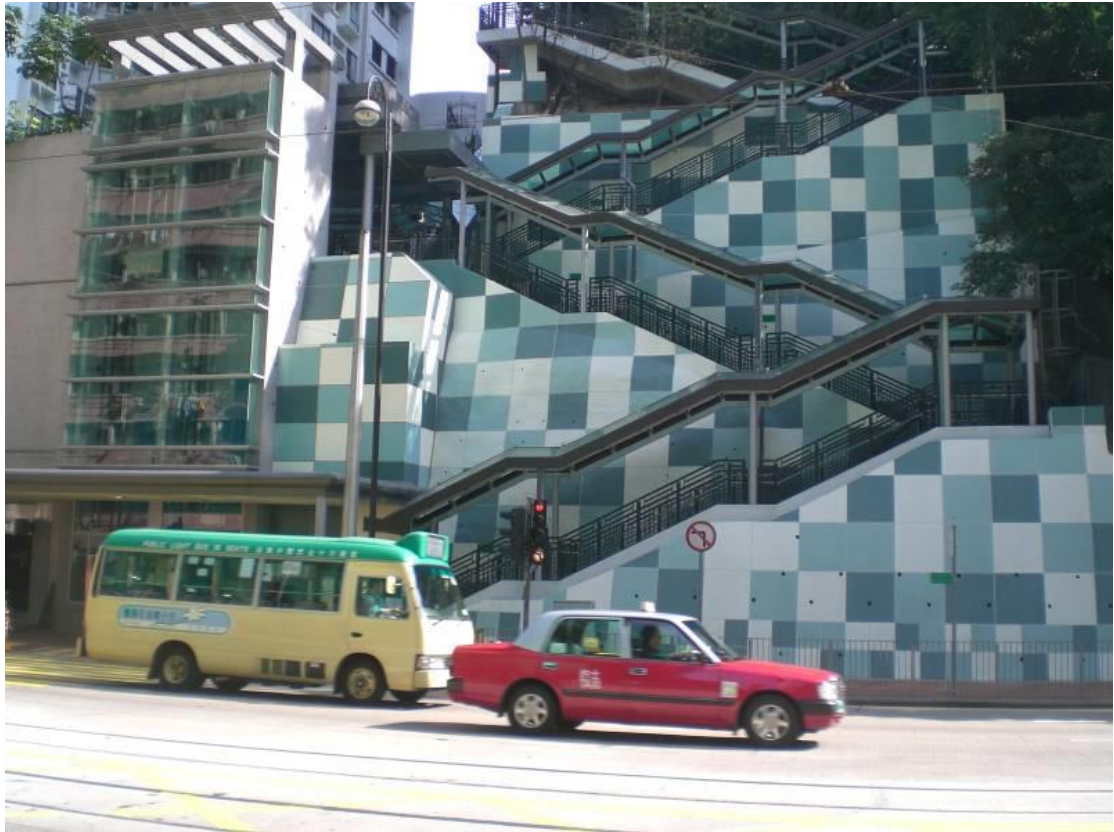
炮台山連接寶馬山扶手及升降機混合系統
