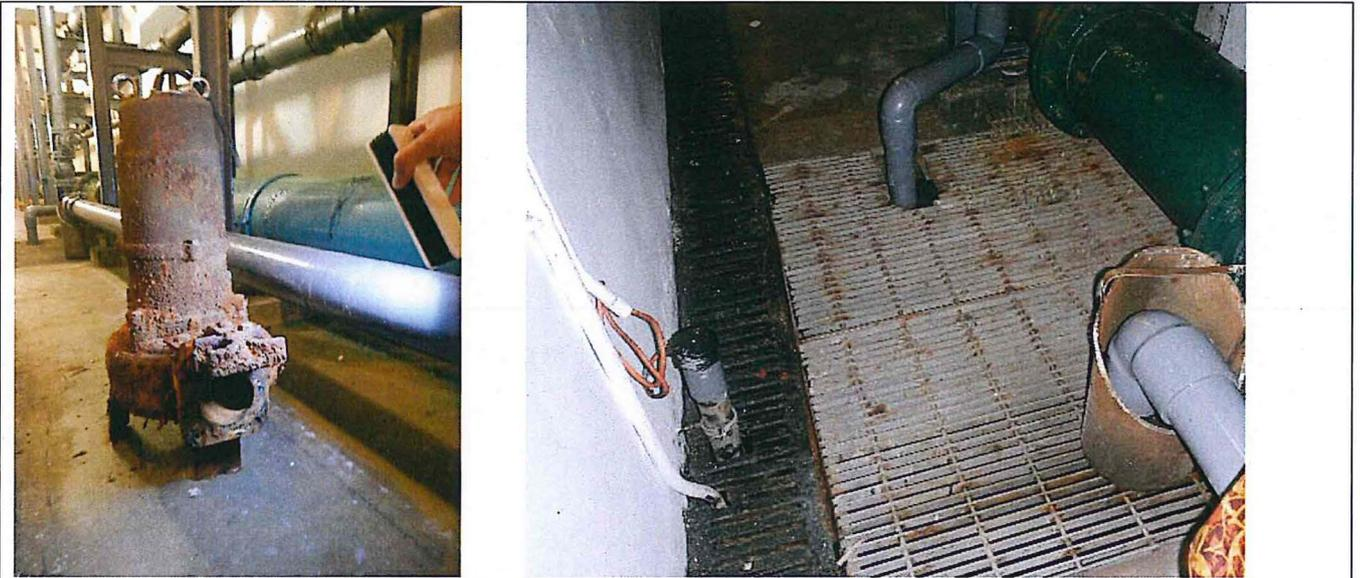
已損壞的潛水泵及其原有位置(鐵絲網底下)
