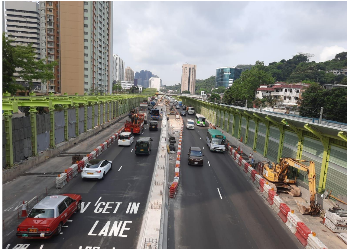
施工中的大埔公路(沙田段)擴闊工程
