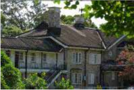
西區抽水站及濾水廠高級職員宿舍(二級歷史建築物)
