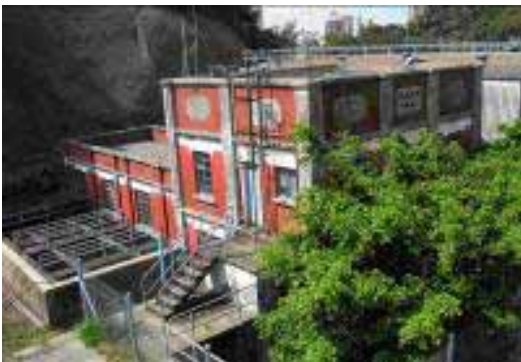
西區濾水廠房(三級歷史建築物)
