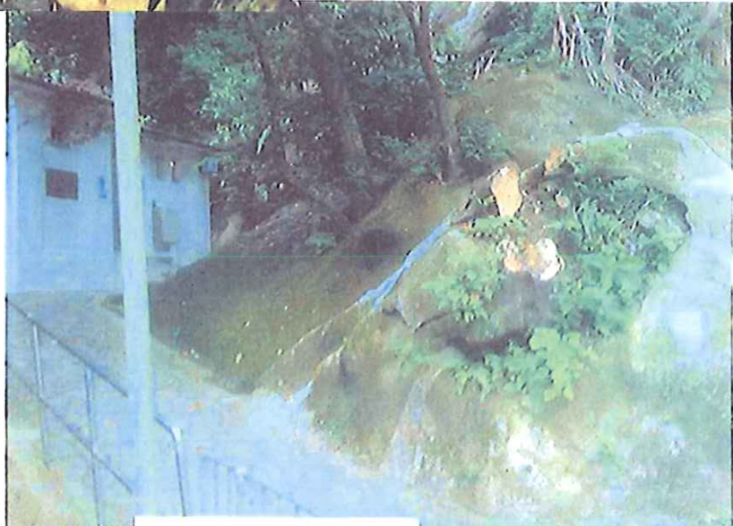
朴樹被移除後
