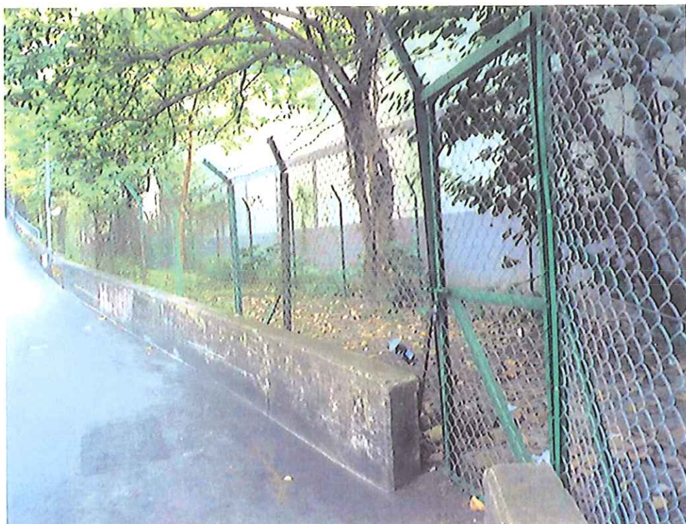
陳捷貴議員提供的工程圖片：改善及美化巴丙頓道 17-19 號瓊峰臺對出空地
