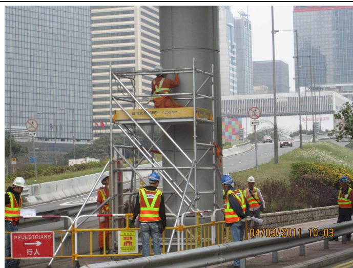
於現有的建築物結構上安裝監測設備
