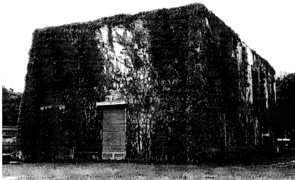
大坑東蓄洪池
