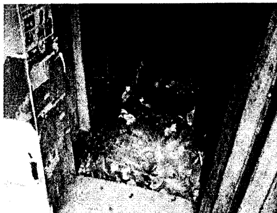
空置大廈外大量 垃圾廢物長期堆積 (福佬村道)
