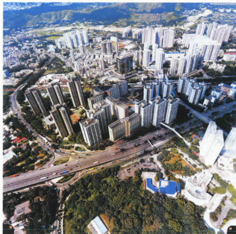
北區主要工程項目進度報告
