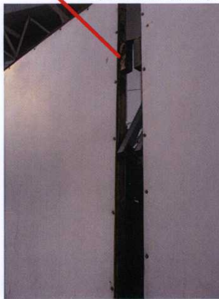
老化生鏽的支架
