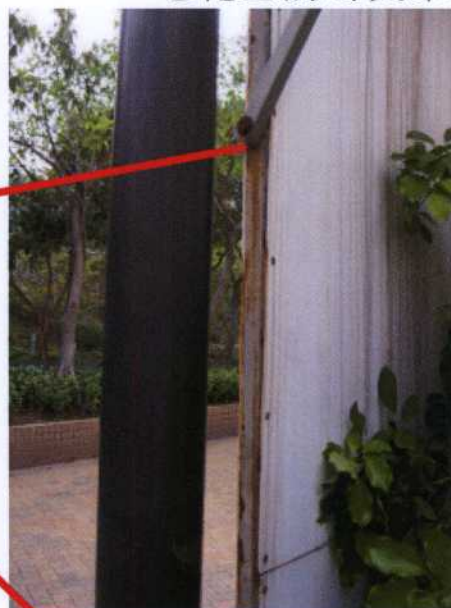
老化生鏽的支架
