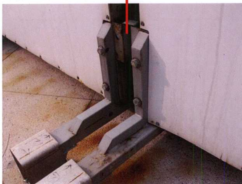
老化生鏽的支架
