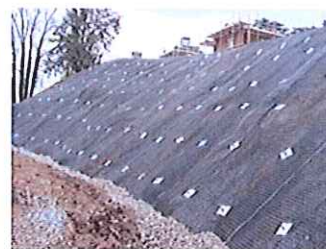
斜坡鞏固工程
