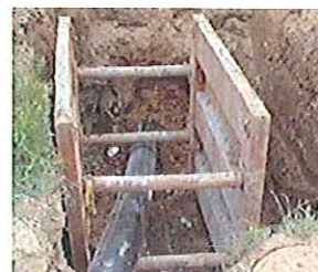
地下管綫改道
