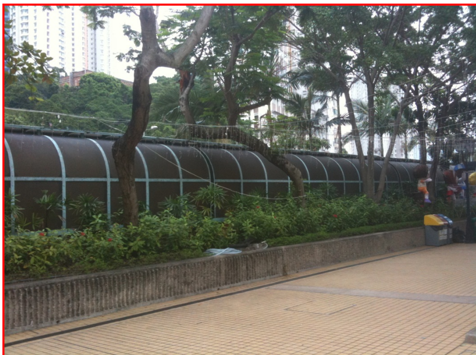
現有隧道狀況
