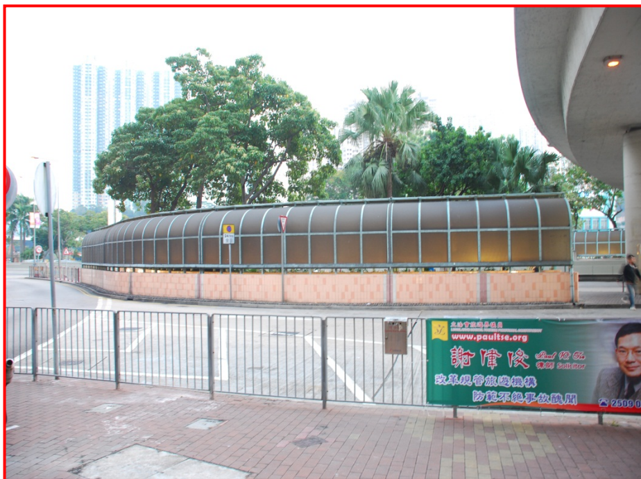
現有隧道狀況
