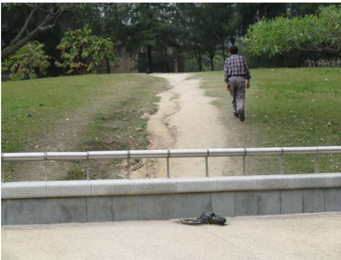
葵涌道天橋旁
