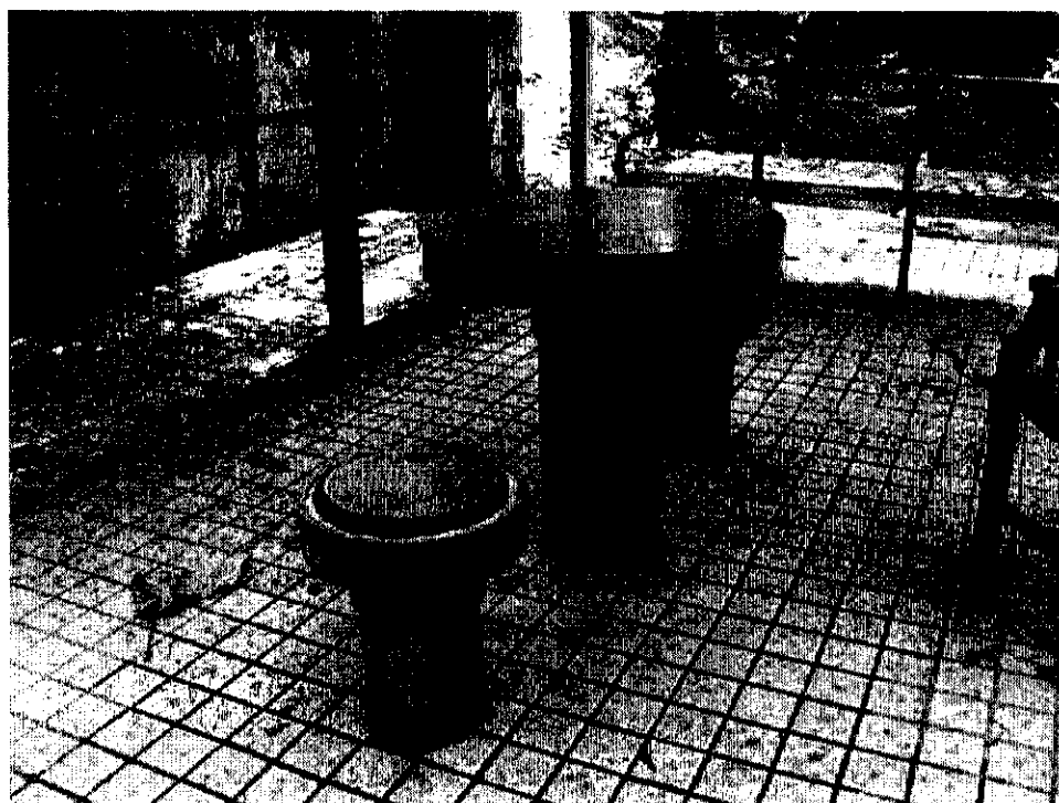
工程地點 (2) 維修涼亭內損壞座椅
