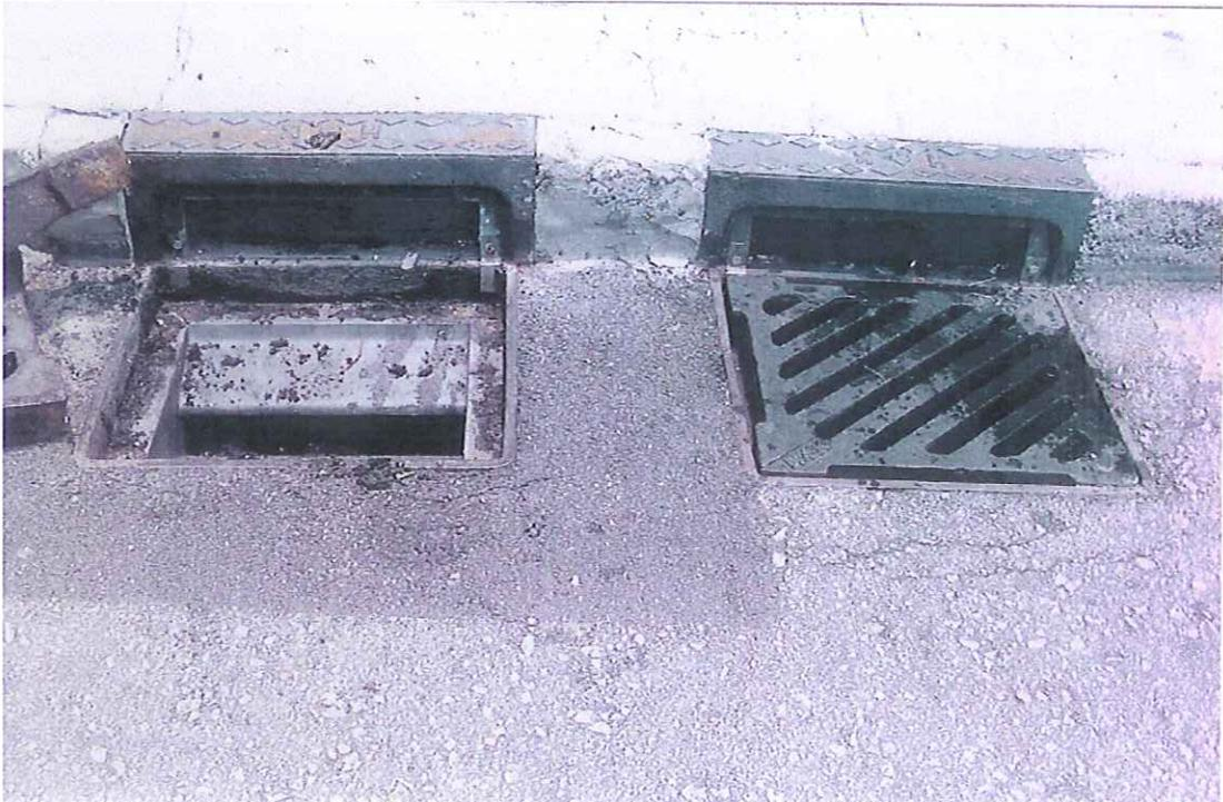
圖 4 現時使用中的沙井有大量積水，每個規格並不一樣
