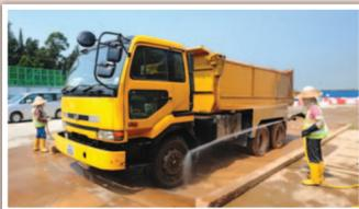
車輛離開工地前會用水清洗車輪，避免泥塵帶出路面
