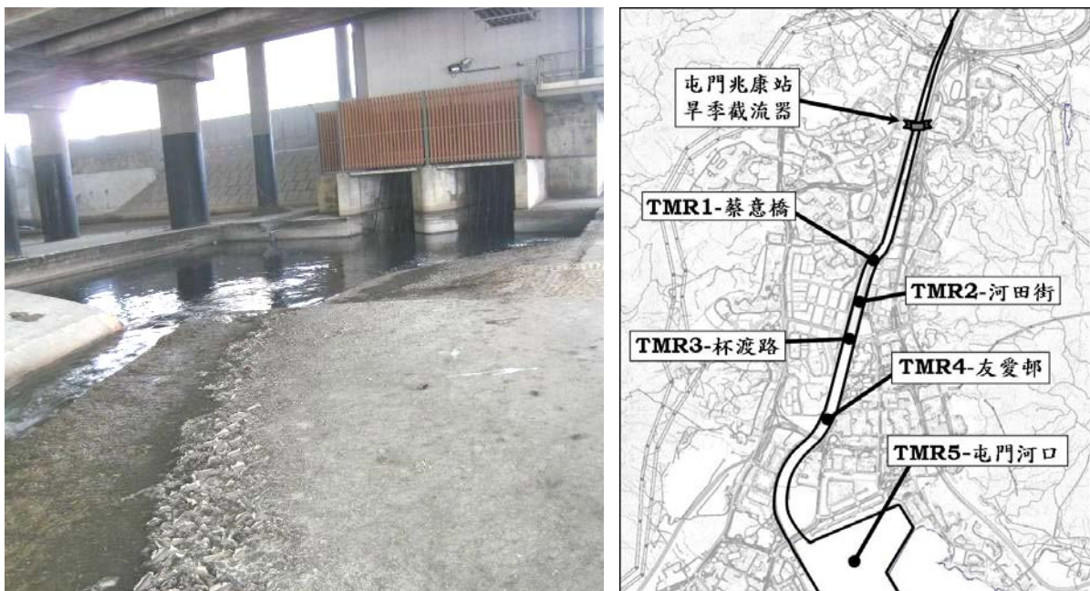
圖一 屯門河西鐵兆康站的旱季截流器及中下游的水質監察站
