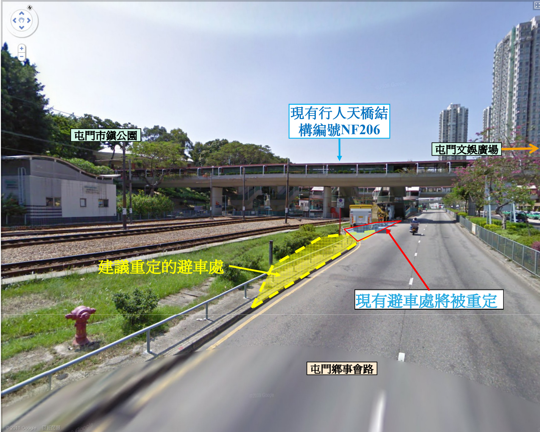
附圖 2B 行人天橋編號 NF127及NF206 – 橫跨屯門鄉事會路由屯門公園至屯匯街及屯門文娛廣場的行人天橋(‘K’出口)
