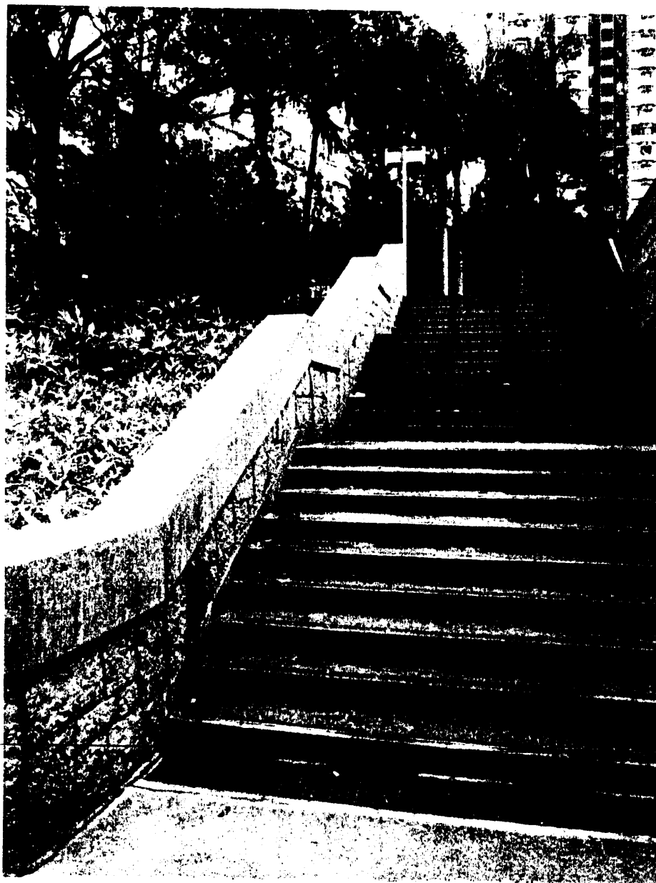
位於太和邨亭和樓側的梯級
