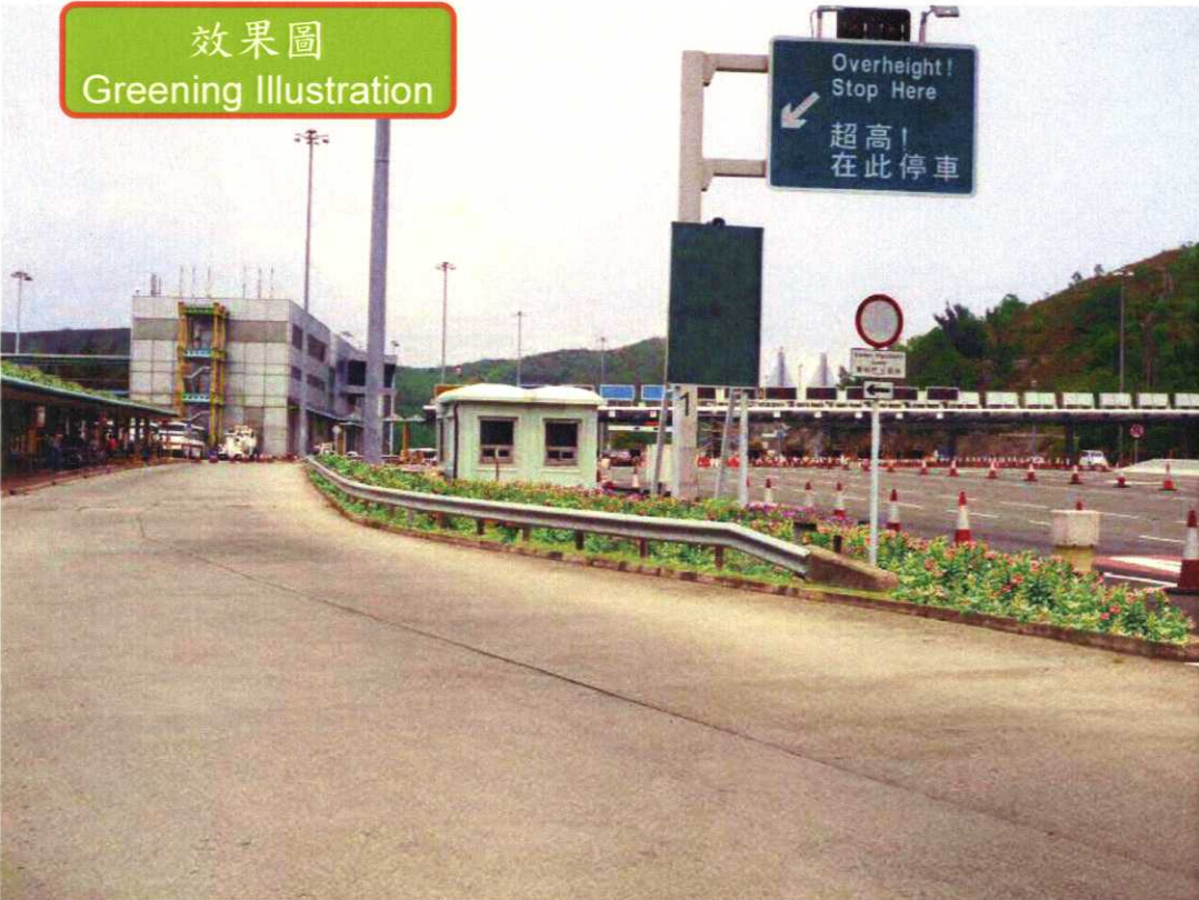
往九龍方向 - 青馬收費廣場 Kowloon Bound - Lantau Link Toll Plaza
