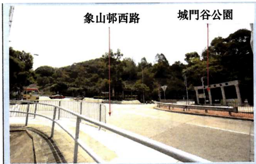
施工前 (於行車路水平直望)
