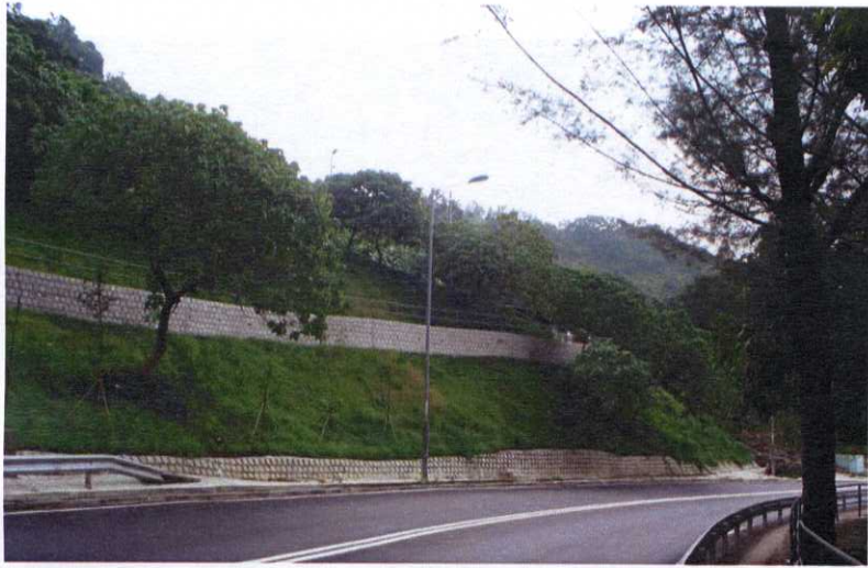
位於荃錦公路的斜坡鞏固工程 (斜坡編號 6SE-B/C236)
