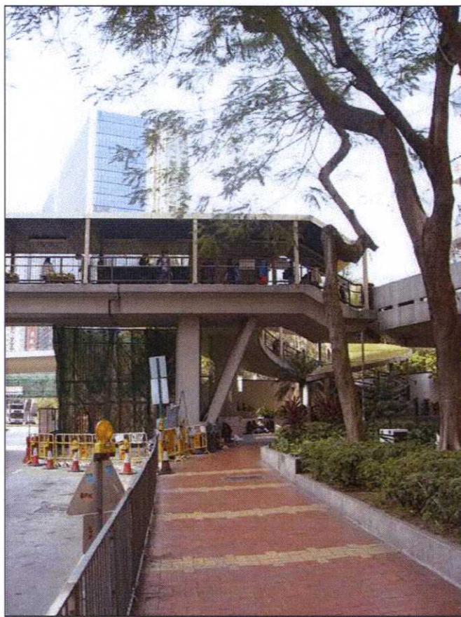
附圖四 現有行人天橋編號 NF109 狀況
