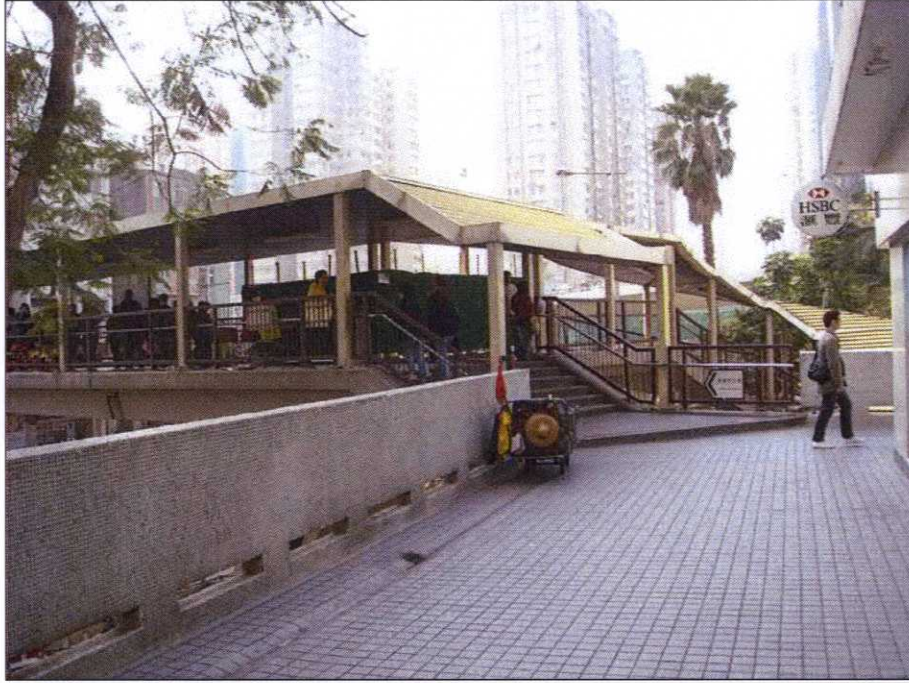
附圖四 現有行人天橋編號 NF109 狀況
