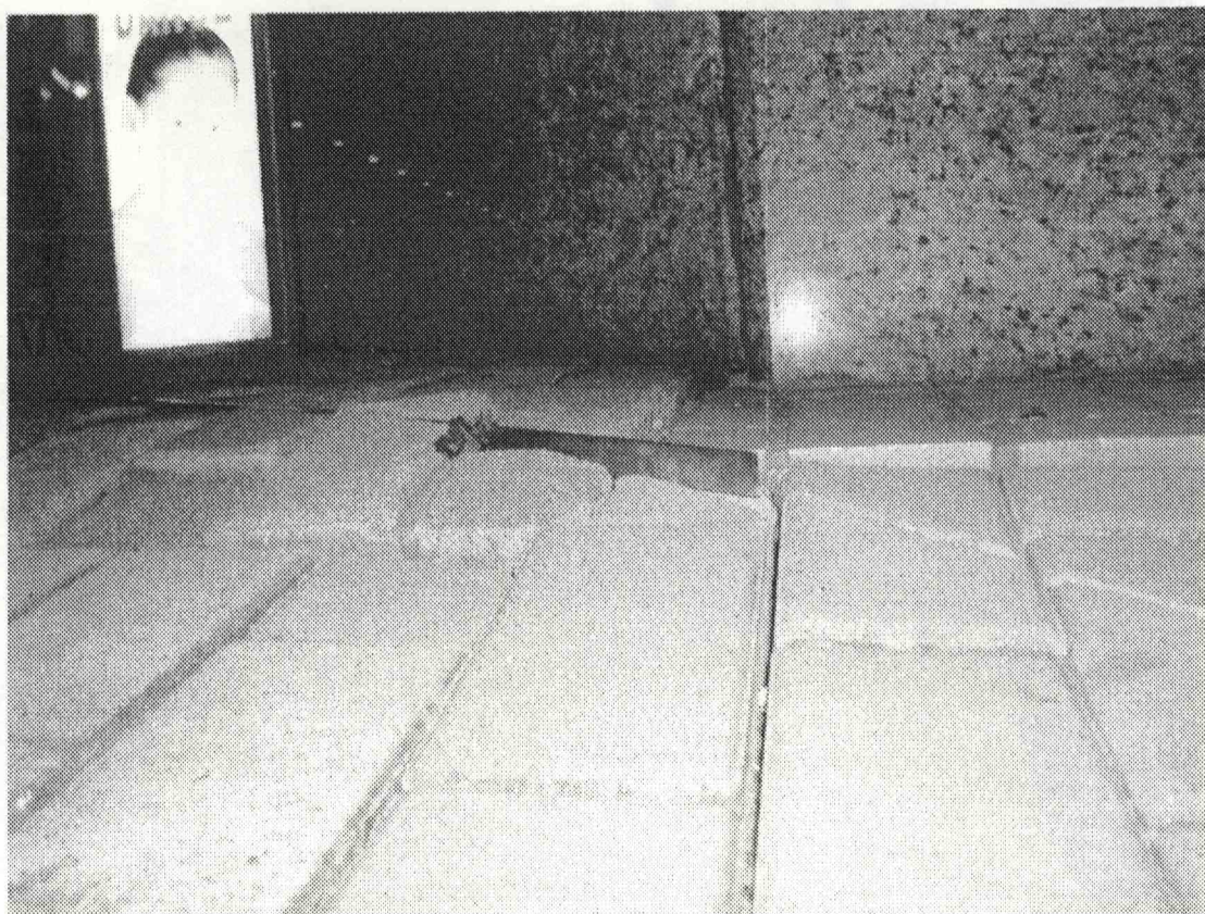
在奧海城第2期幾間地產商舖的外圍路面變得凹凸不平，還露出原本藏在地磚之間的鋼片，對行人構成極度危險。
