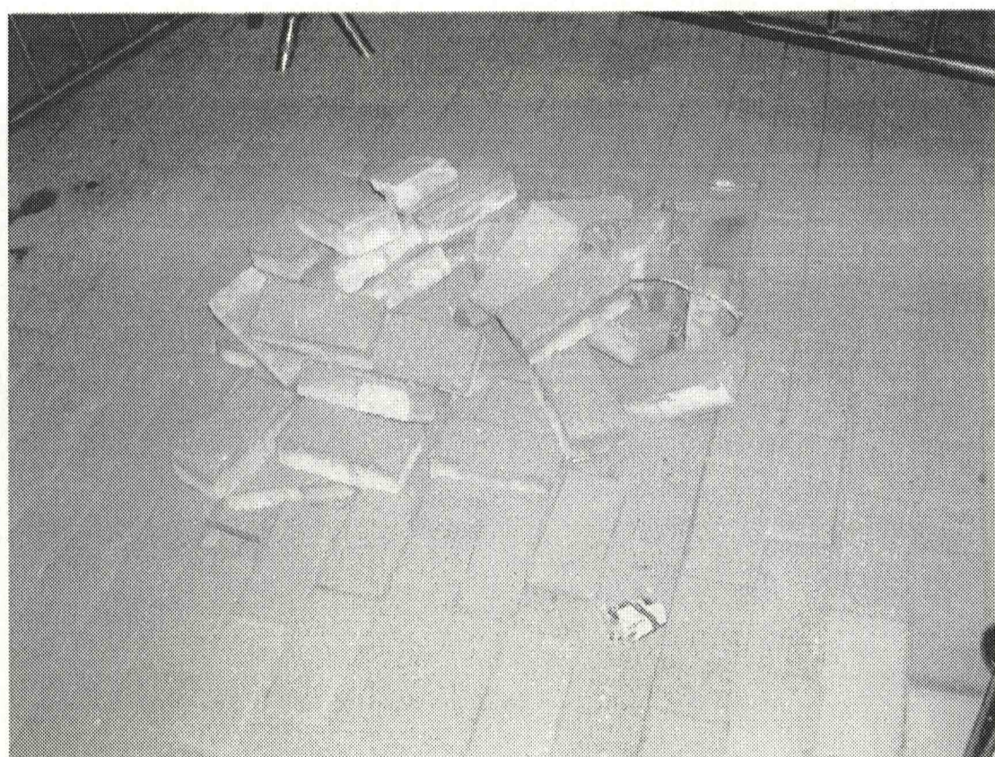
路面破爛不堪，缺乏修理。
