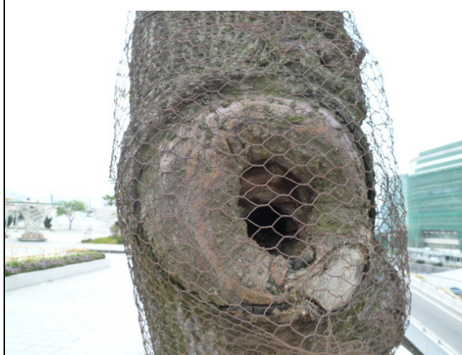
(樹幹樹洞腐爛)
