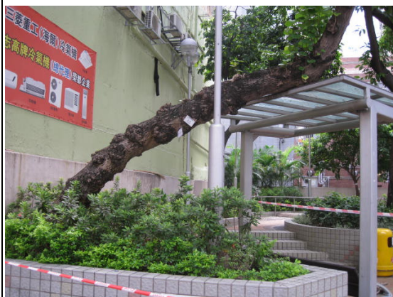
(樹幹嚴重傾斜，結構出現問題)
