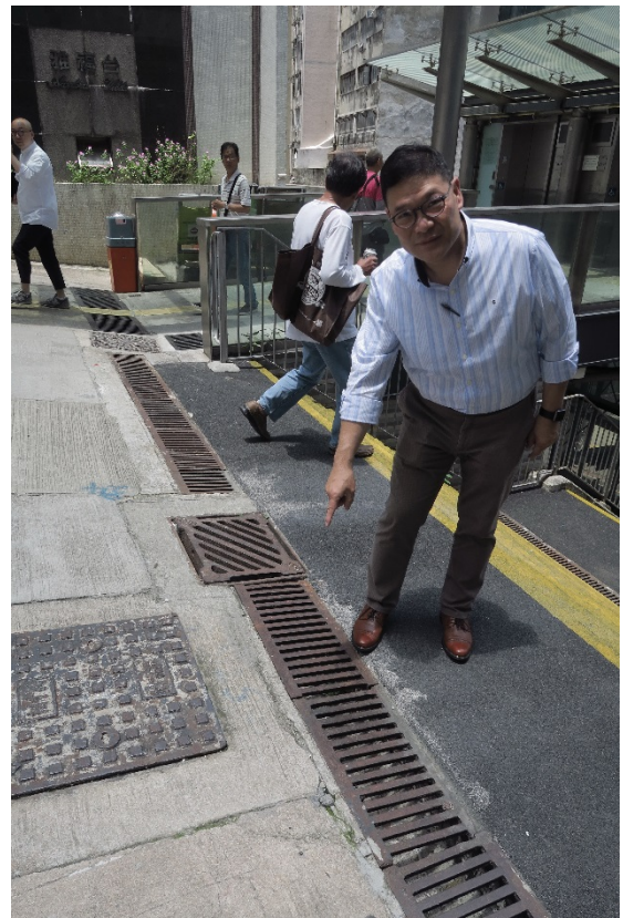
在山市街斜路頂部位置加設去水渠道
