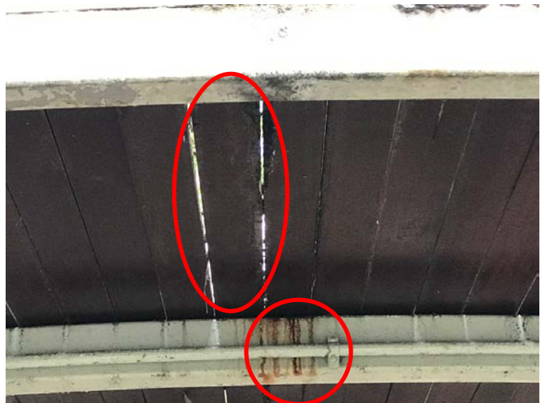
金屬結構出現很多鏽蝕， 啡色結構之間出現空隙及斷裂現象
