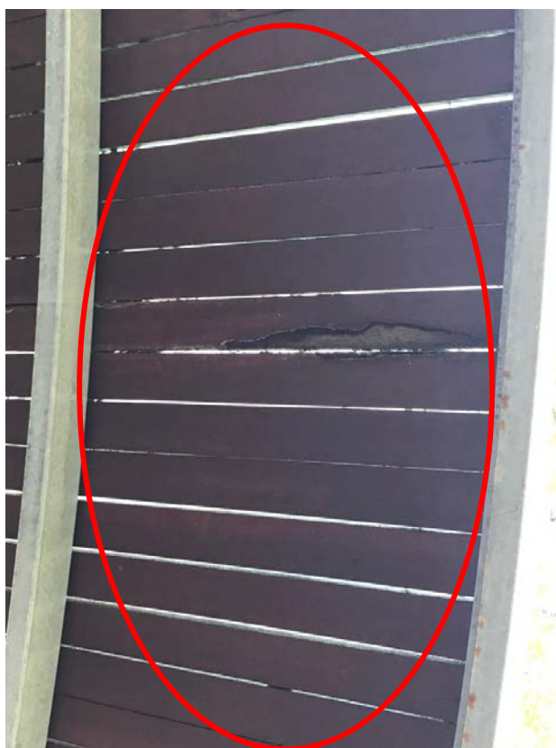
簷蓬頂層的膠片有許多移位 或部份簷蓬更沒有膠片覆蓋
