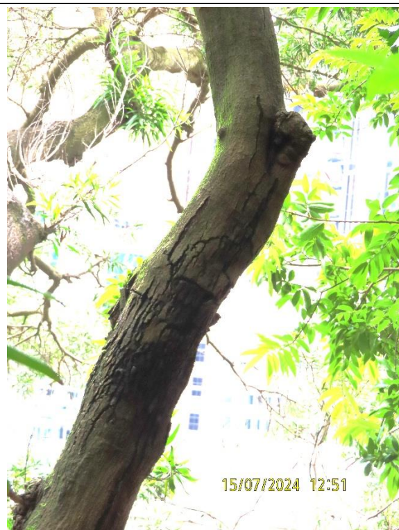
圖片4: 樹木主幹出現不正常樹皮裂紋 - 近觀，可見裂紋數量多，且深而長
