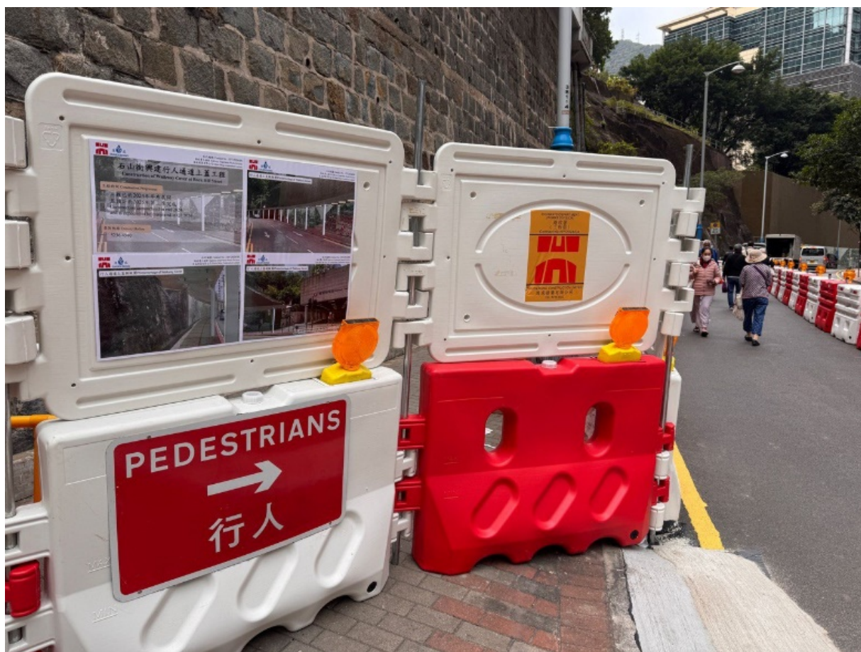
圖 1：在工程圍封範圍貼上告示
