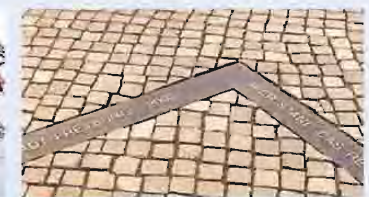
在行人路路面鋪砌圖案，以優化街景 Pavement Pattern to Enhance Streetscape
