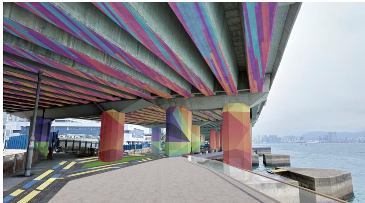
橋底及柱身美化工程
