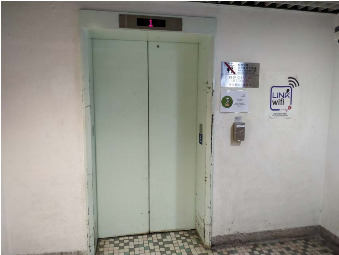
現有耀東商場出口的升降機
