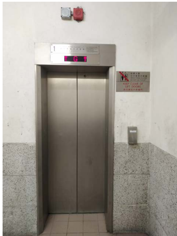
現有耀東邨1號停車場出口的升降機
