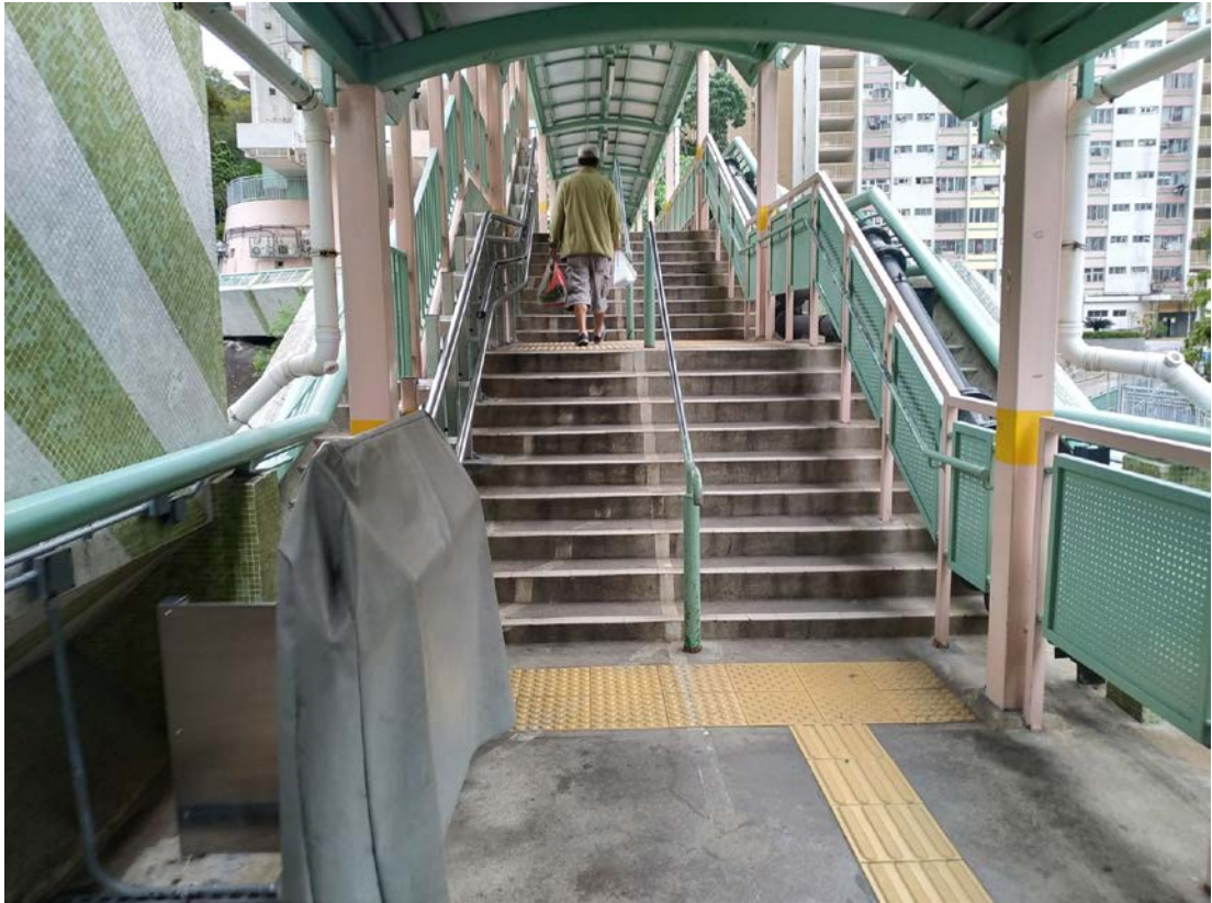
現有行人通道內於近富翠街的樓梯的輪椅升降台
