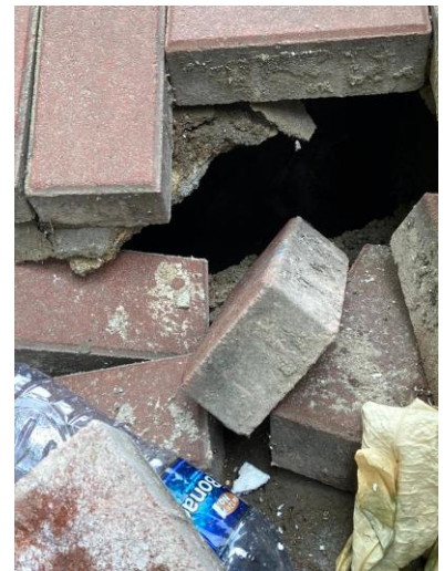
圖五 工廠街地陷內部情況
