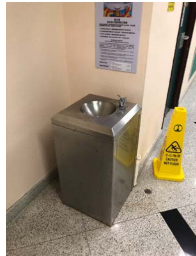
體育館四樓大堂
