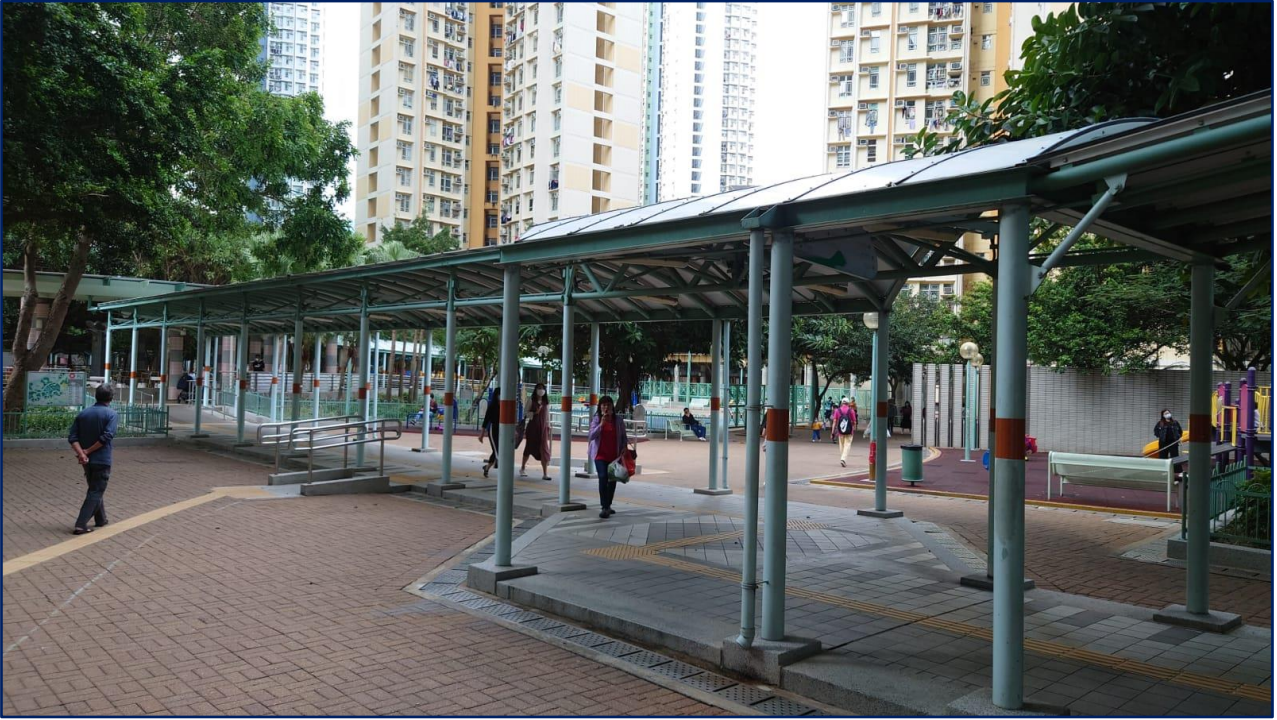
附圖 A - 逸東邨有蓋通道
