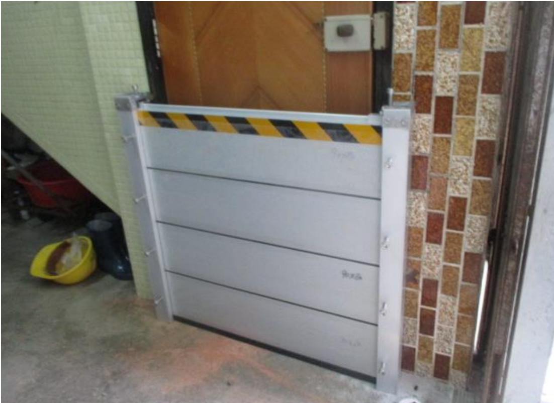
渠務署於太平街北的 20 間房屋安裝了擋水板
