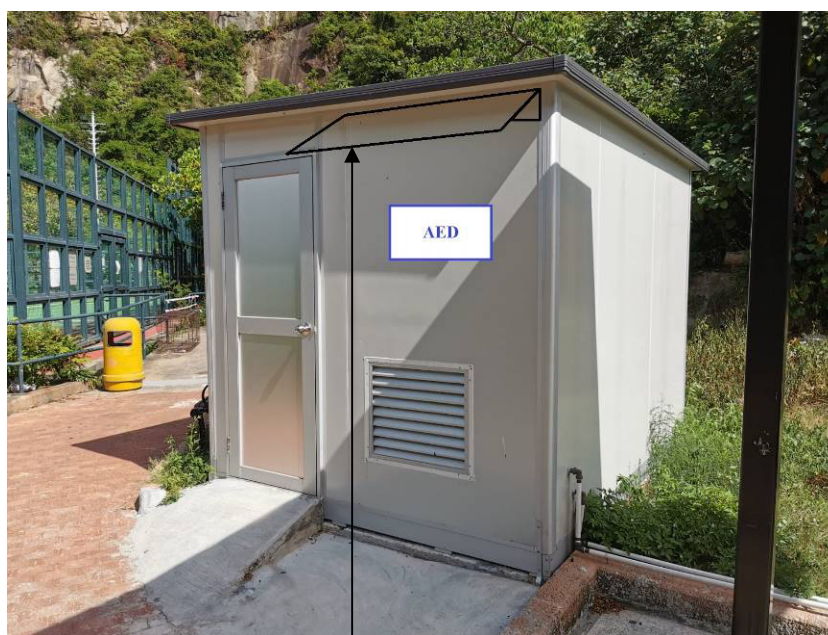
在飲水機泵房外安裝 自動體外心臟去顫器及金屬上蓋
