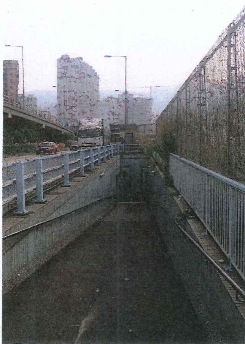
行人隧道編號KS10 C出口：現時情況
