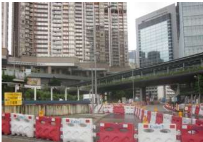
太子道東向土瓜灣方向近工 業貿易大樓工地設置區議會 歡迎牌工程
