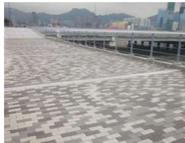
承豐道設置區議會歡迎牌 工程
