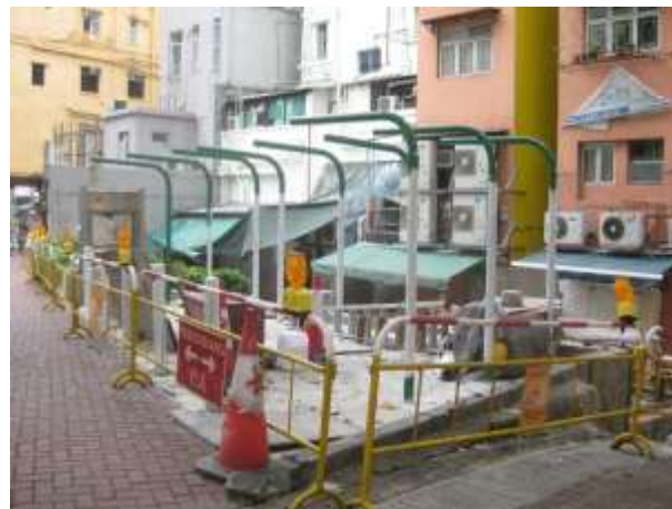
機利士北路休憩處 改善工程
