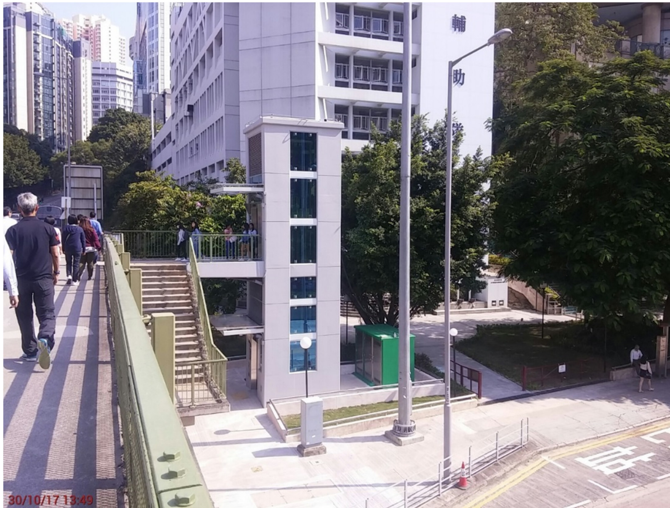
1號升降機照片
