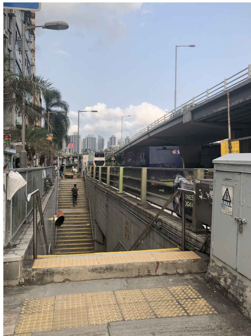
行人隧道編號KS9 A出口：現時情況
