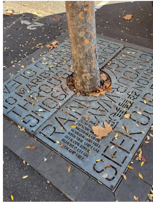
澳洲樹槽蓋板
