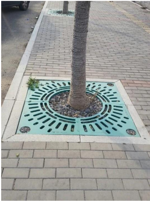
內地樹槽蓋板
